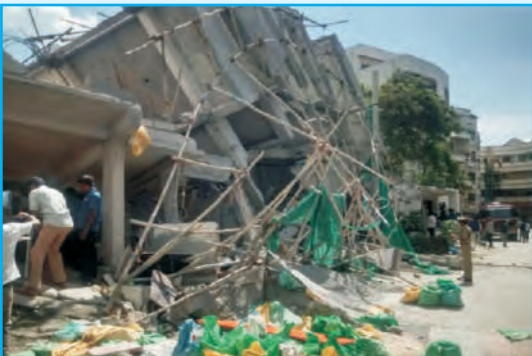
साभार: इंटरनेशनल बिजनेस टाइम्स (दि. 13.10.2016) चित्र 3: नींव का आधार हट जाने के कारण बांद्रा में इमारत ढह गई
